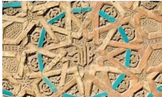
Şek.7 Naxçıvan. Möminə xatun üçün müştərək ornament türbəsinin fasad naxışları.
