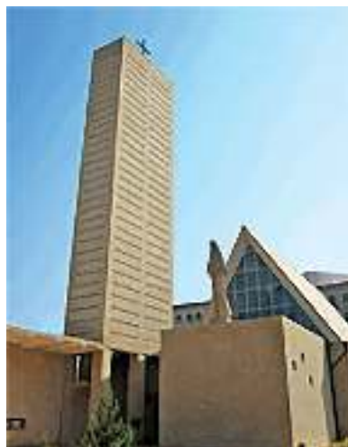
Рис. 2. Церковь Непорочного зачатия, г. Баку, дата основания – 2006
